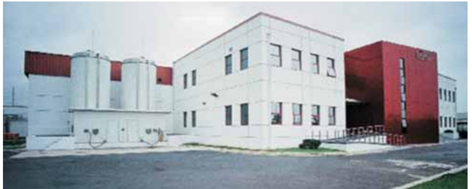
Dairy Creamer Plant, Suzhou / 啤酒厂 苏州
